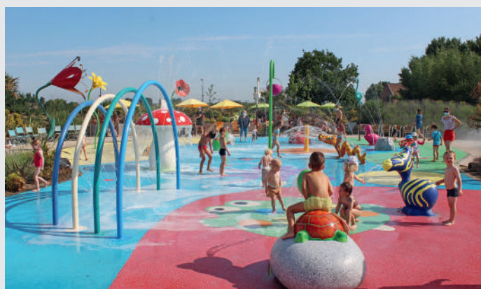
La structure de l'Aquatoon de La Maison de la Piscine est constituée d'une « plage » (radier béton) sur toute la surface de l'aire de jeux. Les éléments hydrauliques et pièces à sceller sont placés en amont. Un bac tampon est également installé. Les jeux sont par la suite disposés sur la plage qui peut être recouverte d'un sol EPDM ou colorée.
