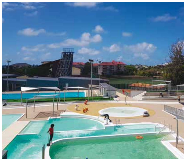
L'établissement, entièrement situé en plein air, comprend notamment deux bassins de 25 m : un sportif et un pour l'apprentissage avec 2 couloirs de natation.
